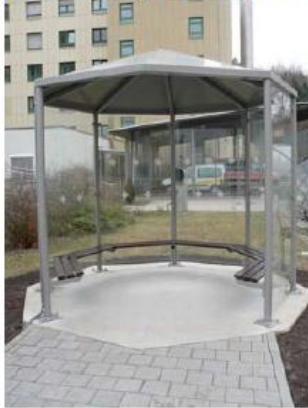
Dübelmontage mit Fußplatte über OKF auf Fundamentplatte
